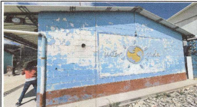
Foto 10: Pintura en muros exteriores e interiores
