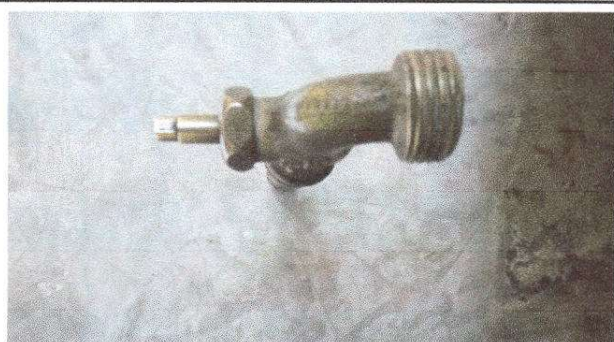
Foto 5: Sustitución de lavamanos
