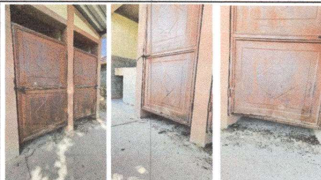
Foto 2: Sustitución de puerta en servicios sanitarios
