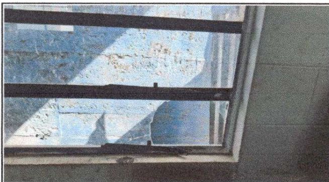
Foto 3: Sustitución de vidrios
