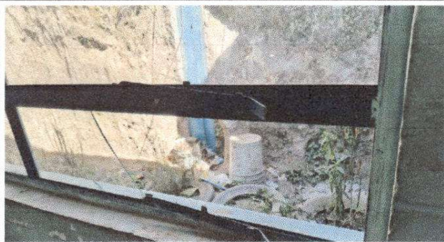
Foto 7: Sustrucción de vidrios
