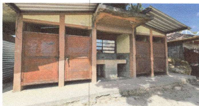
Foto 4: Mantenimiento a estructura (lijado, cambio de tubo , cepillado, sujeciones, aplicación de pintura) a puertas servicios sanitarios
