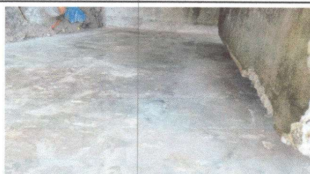
Foto 6: Sustitución de mingitorio
